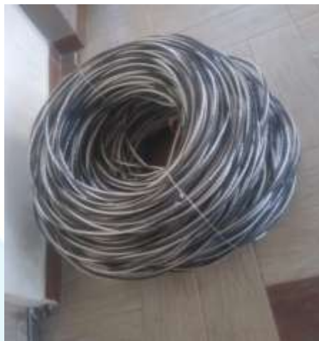
IMAGEN ANTES DE SU EJECUCION
