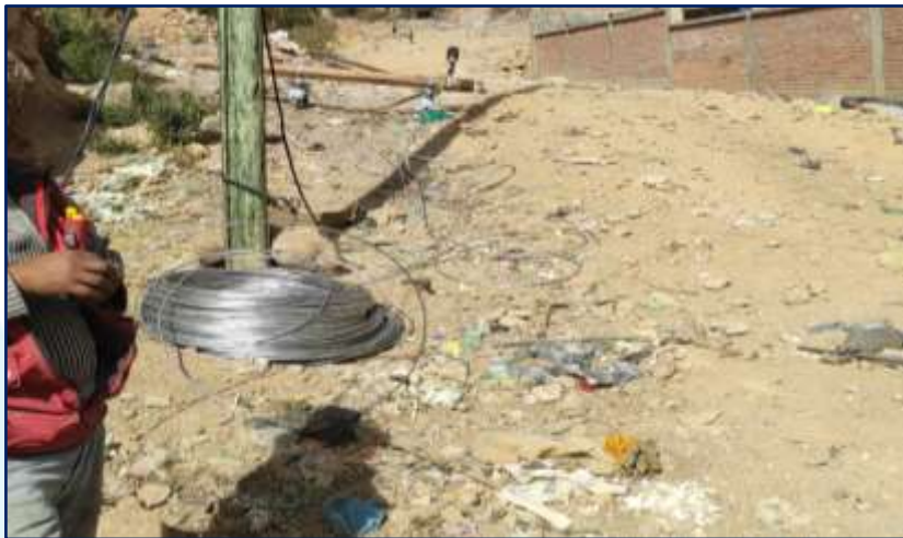
IMAGEN ANTES DE SU EJECUCION
