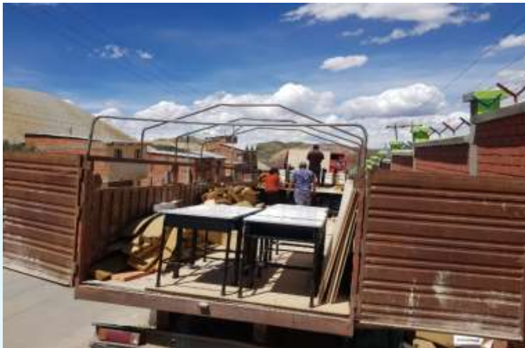
IMAGEN ANTES DE SU EJECUCION
