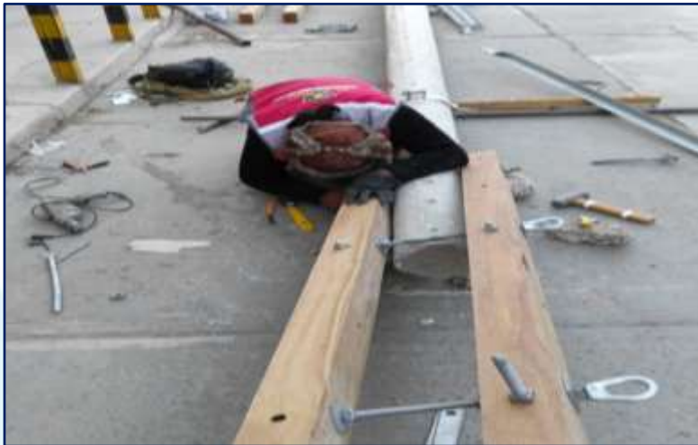
IMAGEN ANTES DE SU EJECUCION
