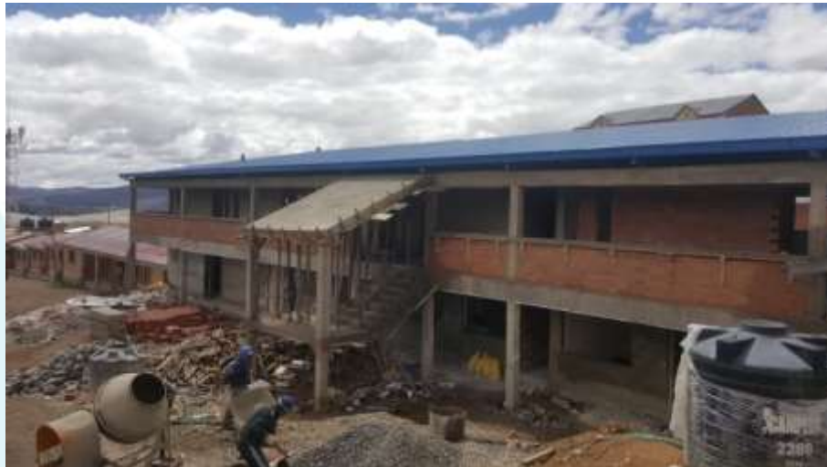
IMAGEN ANTES DE SU EJECUCION
