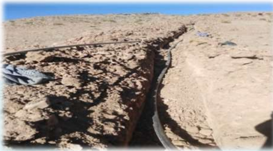
IMAGEN ANTES DE SU EJECUCION
