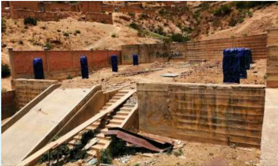
IMAGEN ANTES DE SU EJECUCION
