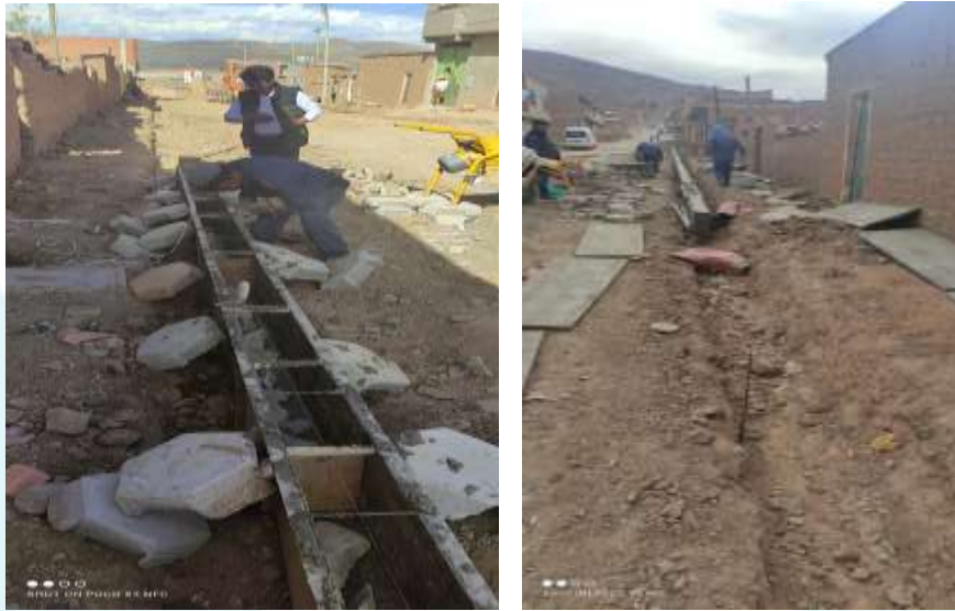
IMAGEN ANTES DE SU EJECUCION
