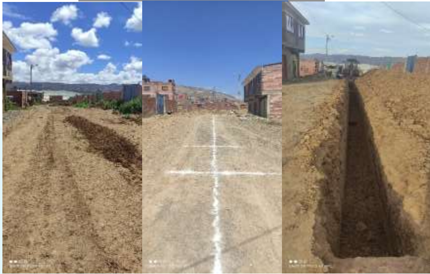
IMAGEN ANTES DE SU EJECUCION
