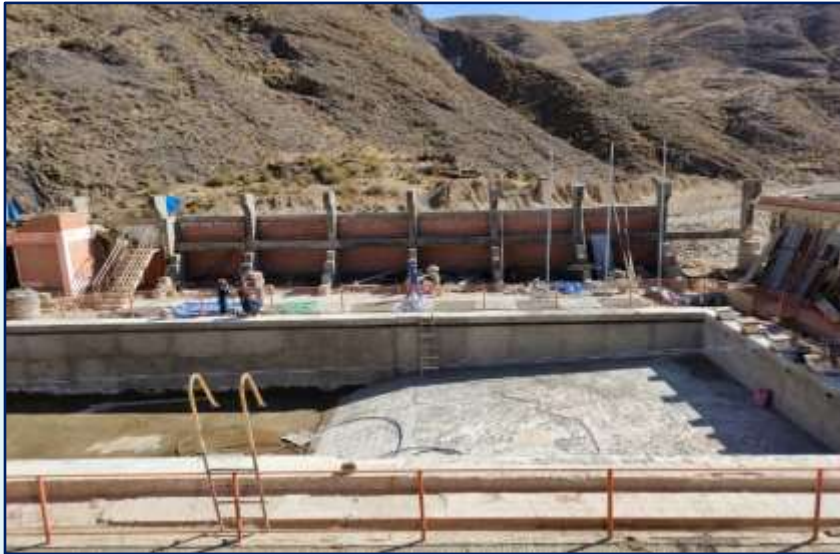
IMAGEN ANTES DE SU EJECUCION
