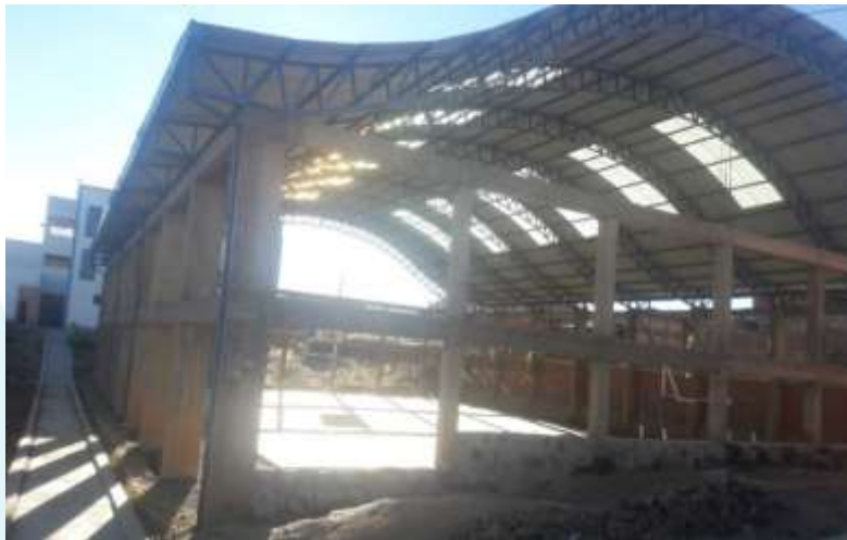
IMAGEN ANTES DE SU EJECUCION
