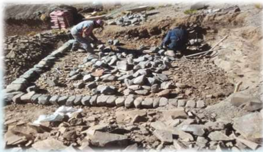
IMAGEN ANTES DE SU EJECUCION
