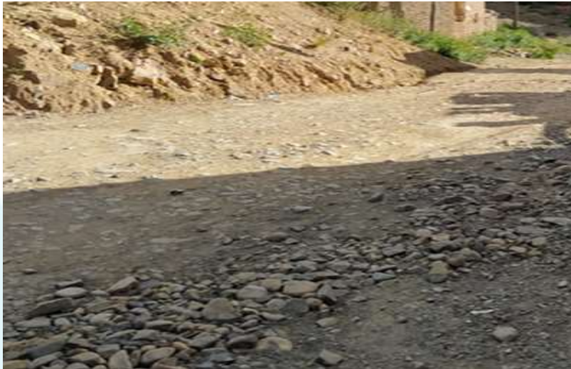
IMAGEN ANTES DE SU EJECUCION
