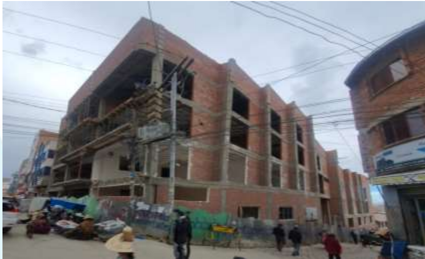
IMAGEN ANTES DE SU EJECUCION
