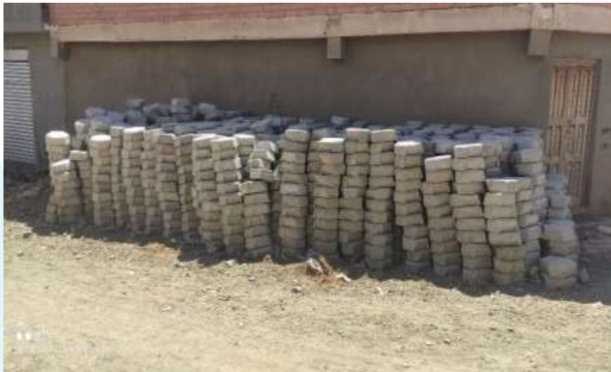
IMAGEN ANTES DE SU EJECUCION
