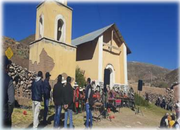
IMAGEN ANTES DE SU EJECUCION
