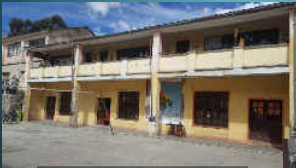
IMAGEN ANTES DE SU EJECUCION
