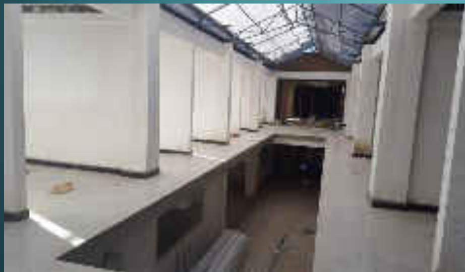
IMAGEN ANTES DE SU EJECUCION
