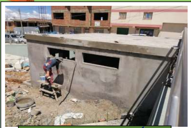
DURANTE LA EJECUCIÓN
